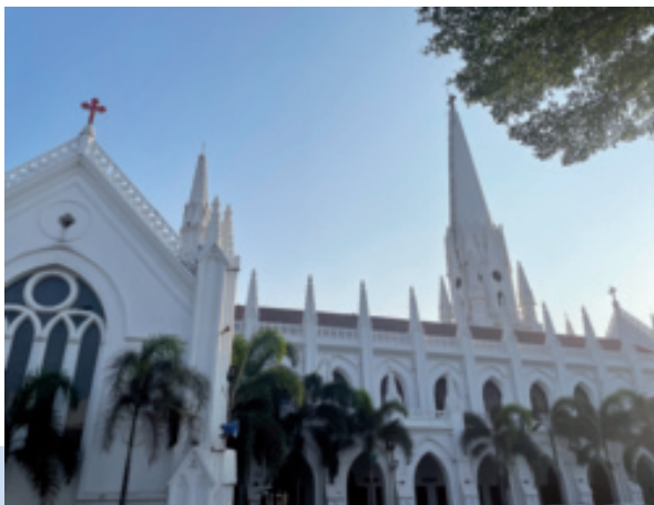
Sanctuaire Saint-Thomas, Chennai
